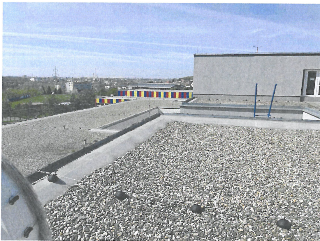
Foto č. 2 – Stávající střešní plášť s kačírkovým posypem bude snesen
